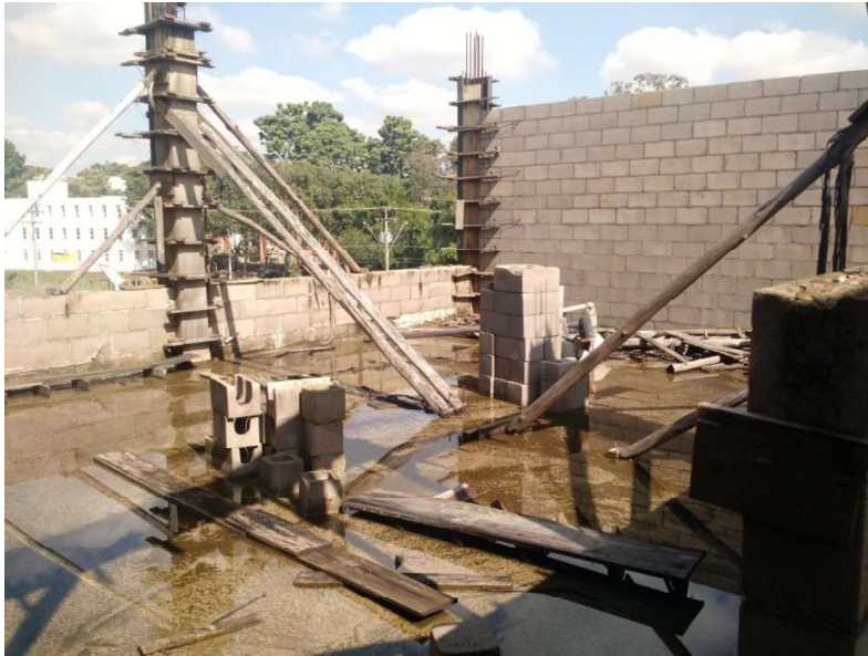
Figura 15: Falta de cobertura no pavimento superior
