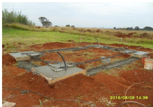
FOTO 28 FUNDAÇÃO CONCRETADA
