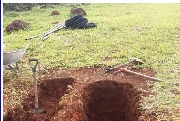
FOTO 06 ESCAVAÇÃO PARA CAIXAS DE PASSAGEM
