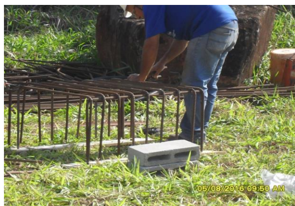
FOTO 17 PREPARAÇÃO DA FERRAGEM DA FUNDAÇÃO
