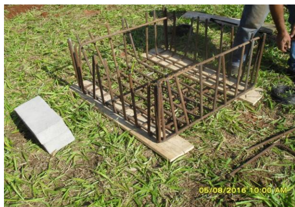
FOTO 18 PREPARAÇÃO DA FERRAGEM DA FUNDAÇÃO
