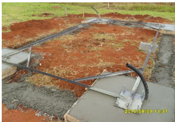
FOTO 27 FUNDAÇÃO CONCRETADA
