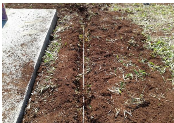
FOTO 50 MALHA ATERRAMENTO DO CONTAINER
