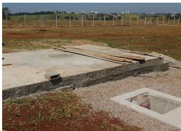
FOTO 52 BASE CONTAINER E CAIXA DE PASSAGEM
