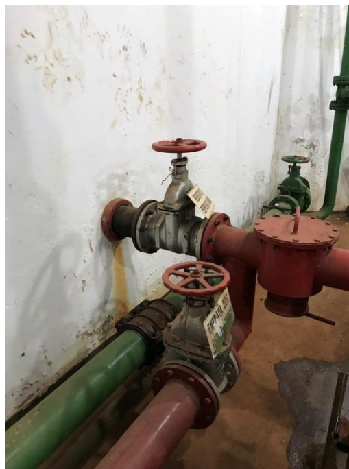
Figura 4. Tubulação de incêndio.
