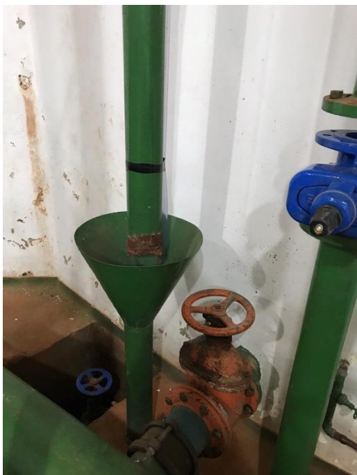
Figura 3. Corrosão de tubulações e peças.
