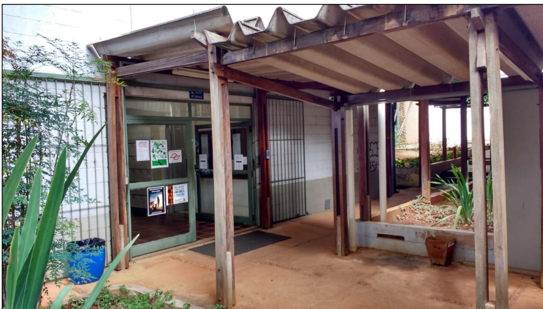
Foto 35: Desmontagem e retirada da cobertura de acesso ao prédio para execução de revestimento de placa cimentícia.
