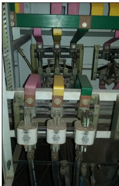
Foto 44: Substituição à uma chave fusível NH3/400A existente
