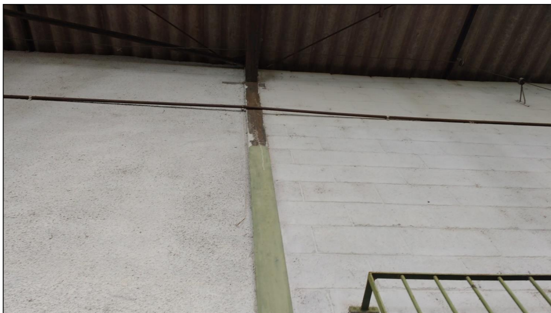
Foto 33: Tratamento dos pilares com lixamento e aplicação de prime anticorrosivo e pintura em esmalte sintético.
