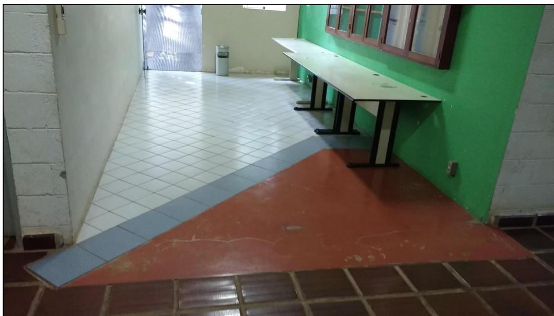
Foto 13: Demolição de piso, camada de regularização e rodapé.
