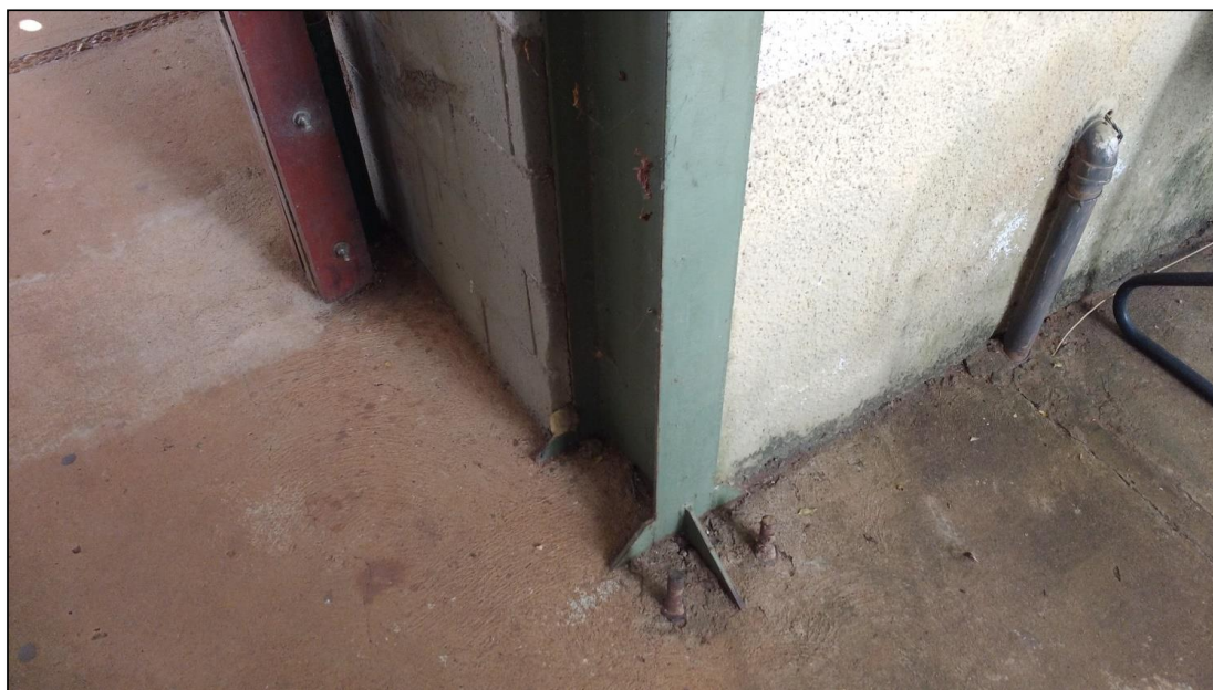
Foto 30: Tratamento dos pilares com lixamento e aplicação de prime anticorrosivo e pintura em esmalte sintético.
