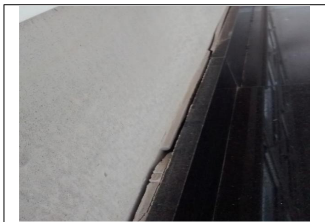
Foto 64: Aplicação de silicone entre os vãos do frontão das bancadas e as placas de pré-moldadas
