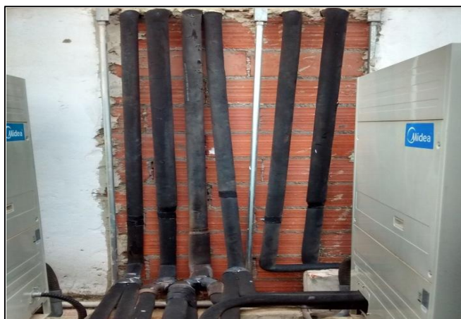
Foto 72: Chapa galvanizada nº 22 instalada sobre e atrás da tubulação de ar condicionado
