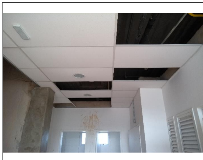
Foto 76: Forro de placa mineral a ser retirado e re-instalado para execução do reforço da estrutura sob a laje das caixas d'água.
