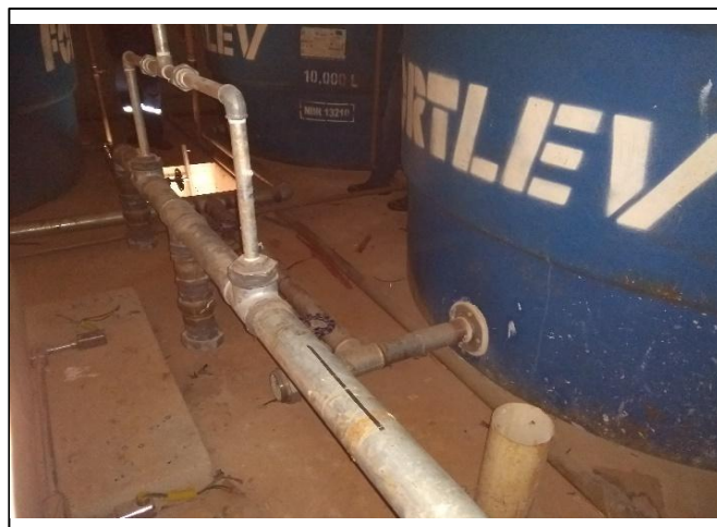
Foto 75: Detalhe das tubulações do barrilete a serem desligadas e religadas devido a execução do reforço da estrutura da laje
