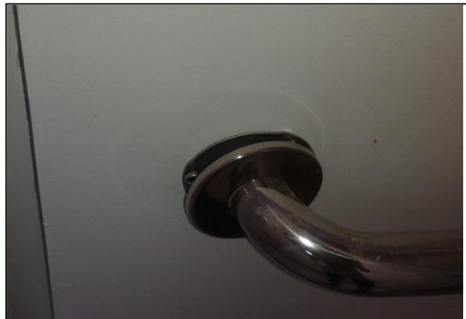
Foto 43: Fixação do puxador para porta de sanitário PNE
