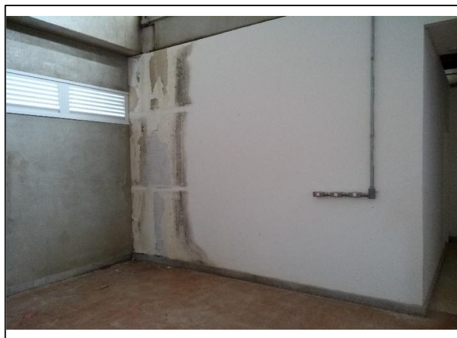
Foto 26: Troca de divisória de gesso acartonado
