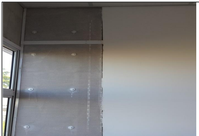
Foto 65: Acabamento entre parede de gesso acartonado e shaft
