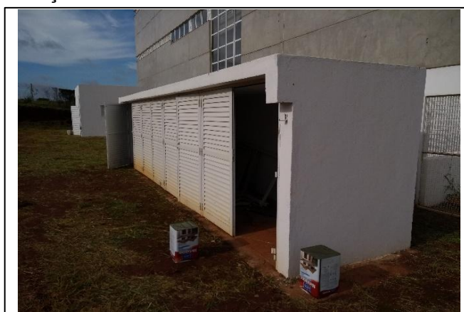
Foto 18: Impermeabilização à base de emulsão acrílica (Abrigo de Gases)
