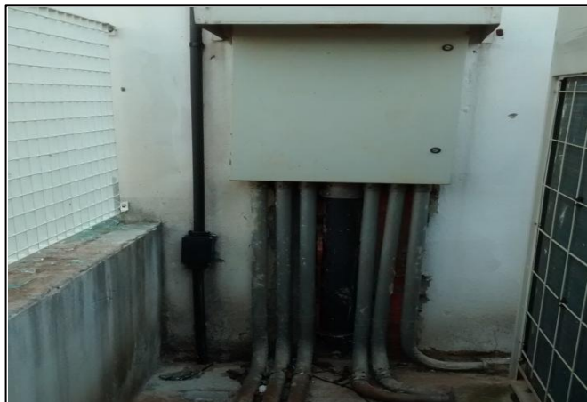
Foto 73: Cobertura do quadro de AC e instalação de chapa galvanizada nº 22 atrás da tubulação
