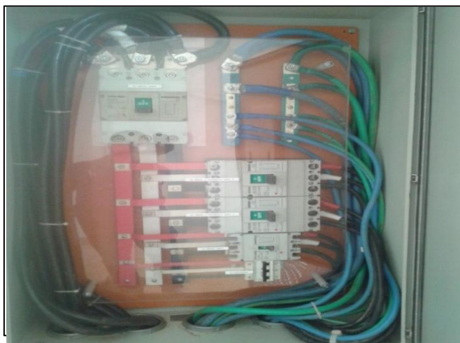
Foto 15: Troca de Quadro QGEC por Quadro Elétrico 1600 x 800 x 200
