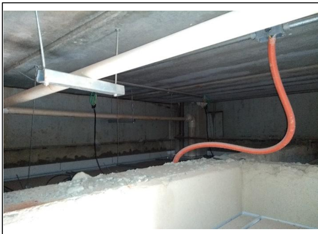
Foto 74: Local de instalação das vigas (H) de reforço sob a laje das caixas d'água, as tubulações que vierem a interferir na execução do reforço deverão ser remanejadas
