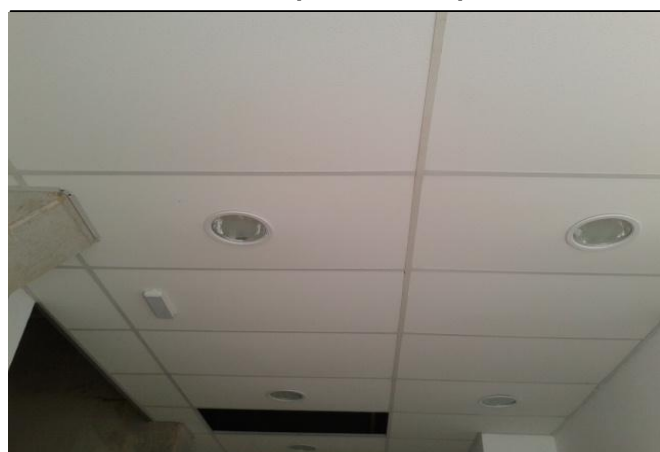
Foto 50: Bloco aut balizamento (sinalização de saída)
