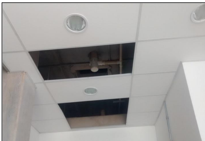
Foto 45: Novas placas / troca de placas danificadas
