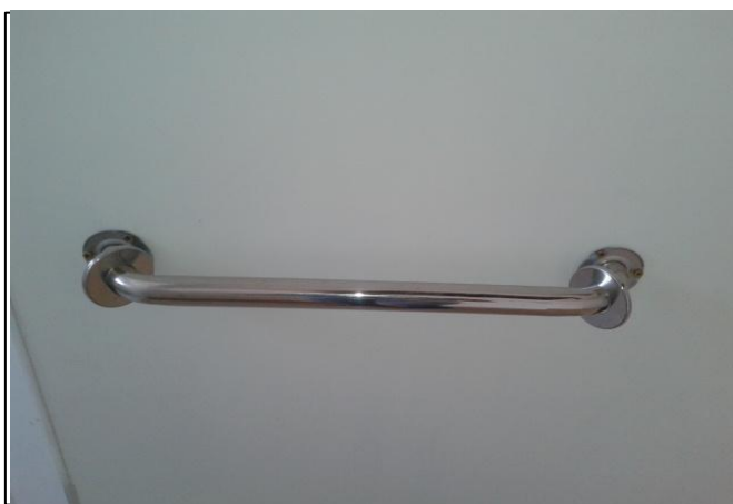
Foto 55: Fixação do puxador porta de sanitário PNE
