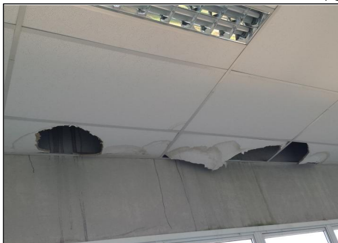
Foto 35: Novas placas / troca de placas danificadas
