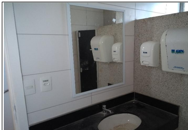
Foto 30: Verificação e fixação de Dispenser para sabonete
