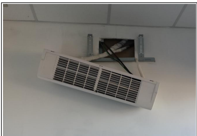
Foto 61: Fixação de aparelho de ar condicionado
