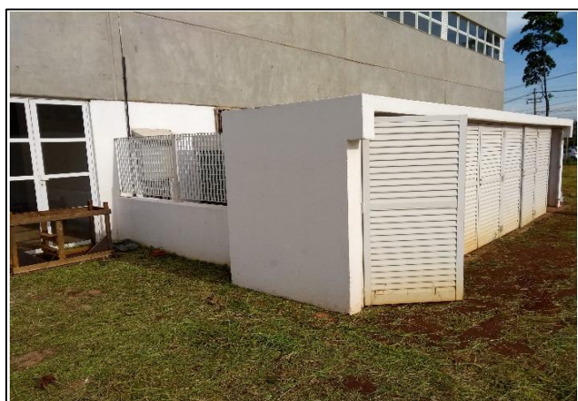
Foto 05: impermeabilização com emulsão acrílica
