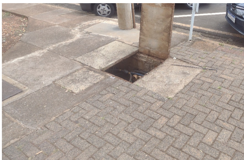
Figura 6 - Caixa de Intercepto
