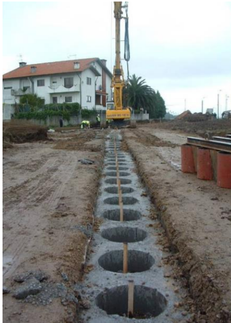
Figura 1. Mureta guia executada para cortina de estacas espaçadas.
