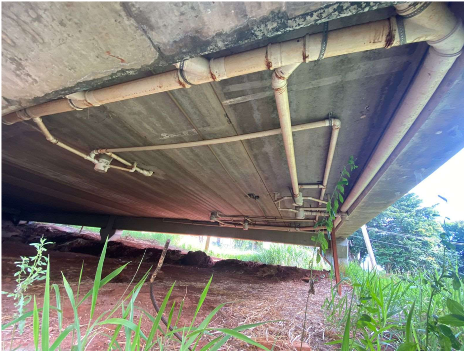
Foto 19: Rede de esgoto do auditório
