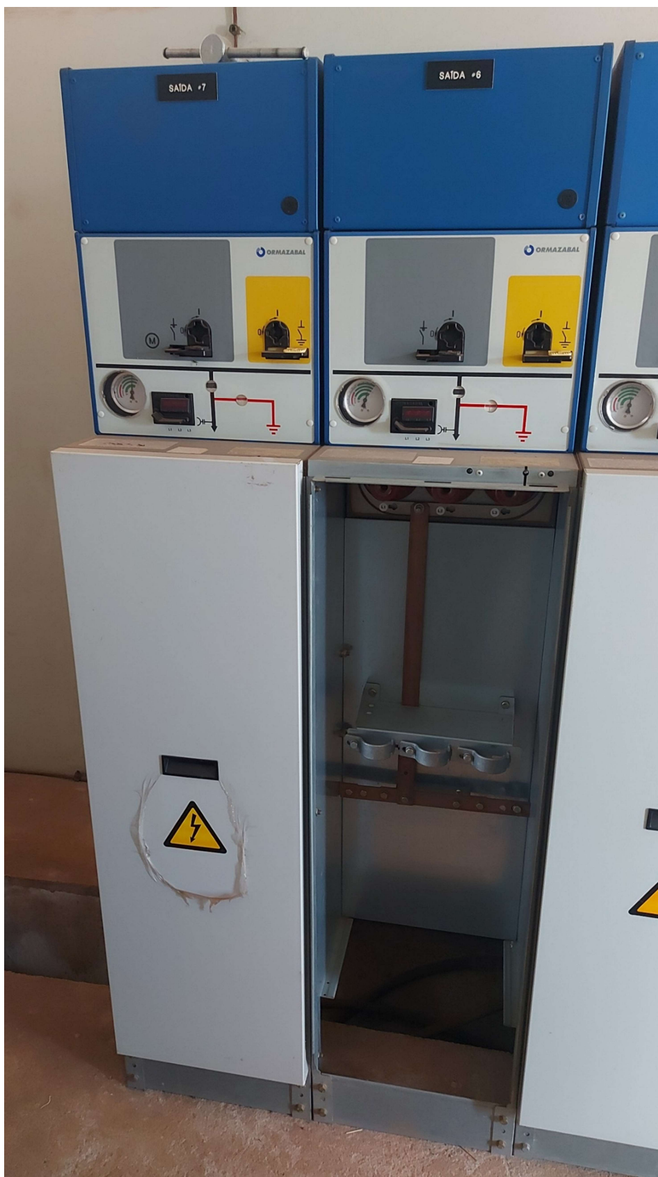
Cubículo blindado de média tensão Cabine Geral (ponto de conexão para novo circuito)
