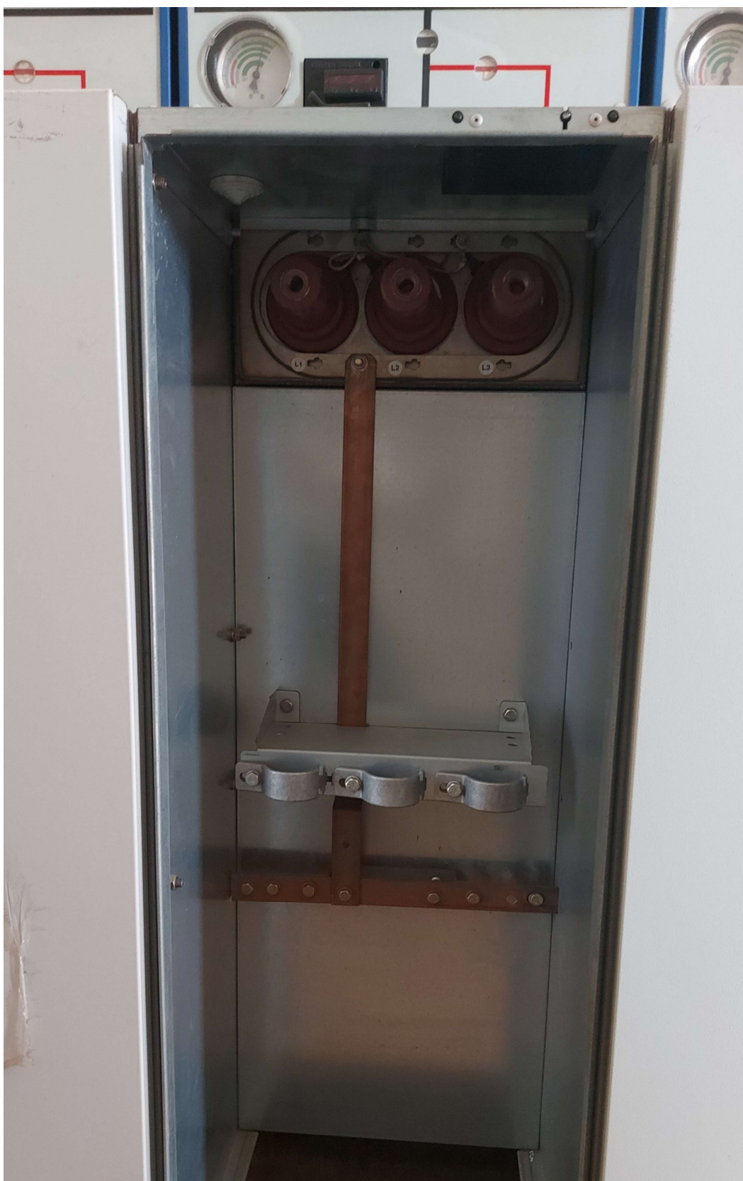
Cubículo blindado de média tensão Cabine Geral (ponto de conexão para Muflas, entrada para cabos de média tensão a serem instalados)
