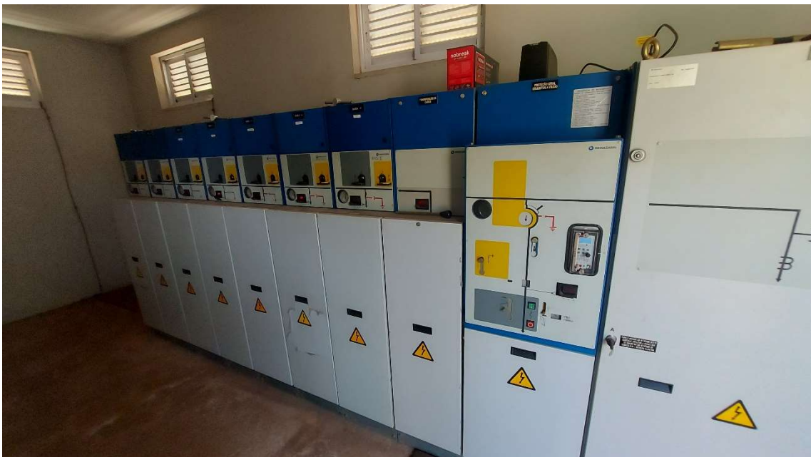
Cubículo blindado de média tensão Cabine Geral (vista externa)
