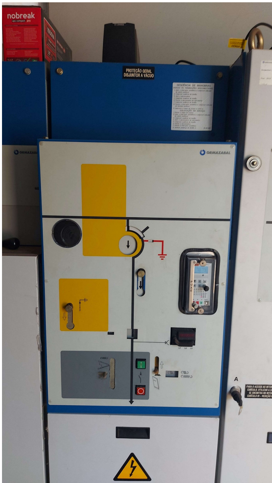
Cubículo blindado de média tensão Cabine Geral (Disjuntor Geral de média tensão)
