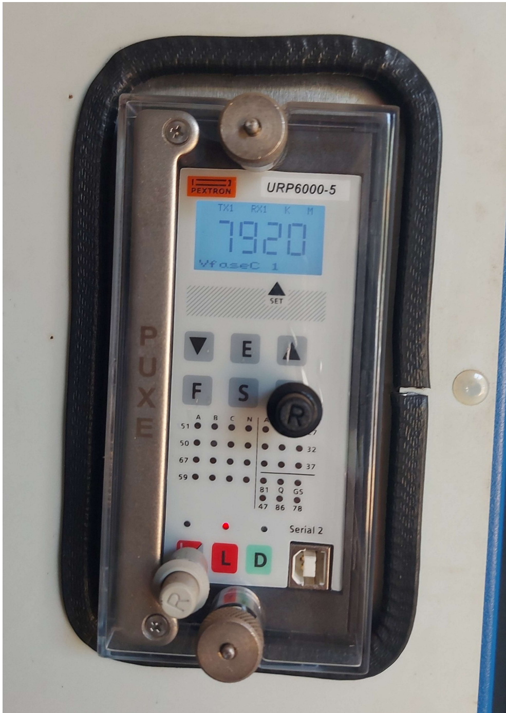
Cubículo blindado de média tensão Cabine Geral (Relé de proteção da média tensão)
